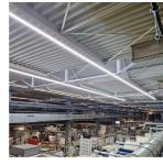
**Technische Daten Retrofit Tragschiene Modul 32W/40W/48W/55W Max 12580lm 90D - 840 Kaltweiß | 1500mm - 3 Stunden Notlicht**
